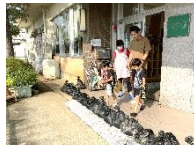
玄関前には土嚢を並べ、水害に備えます。
